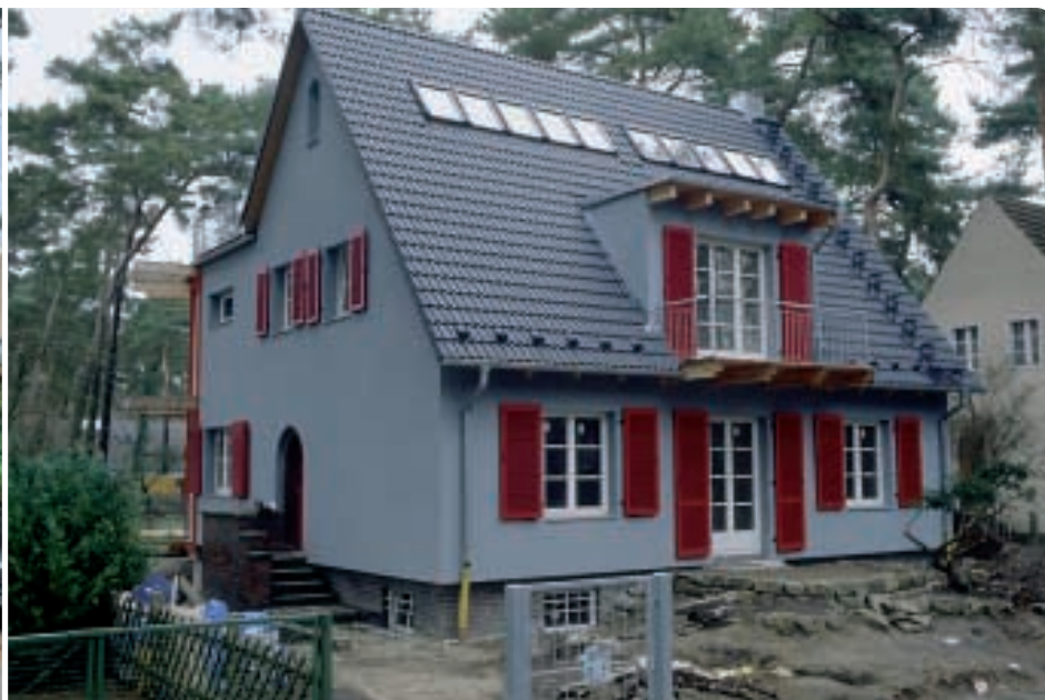
Nach der Modernisierung
