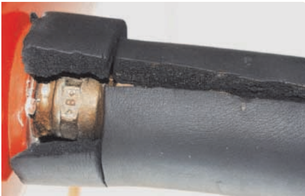
Mangelhafte Rohrdämmung
