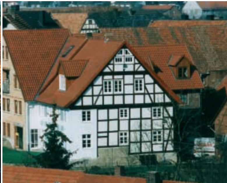
Nach der Modernisierung
