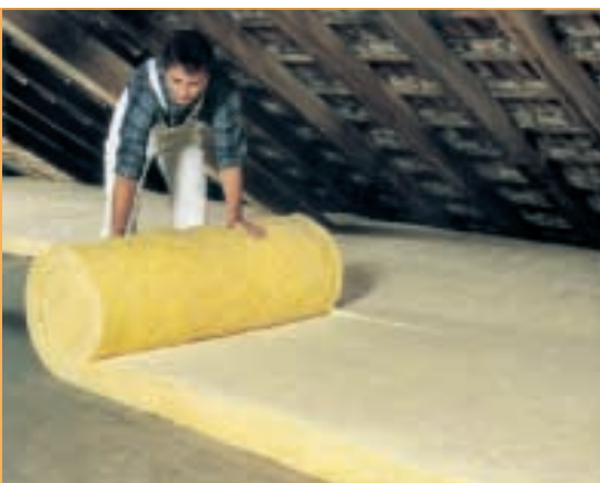
Dämmung oberste Geschossdecke
