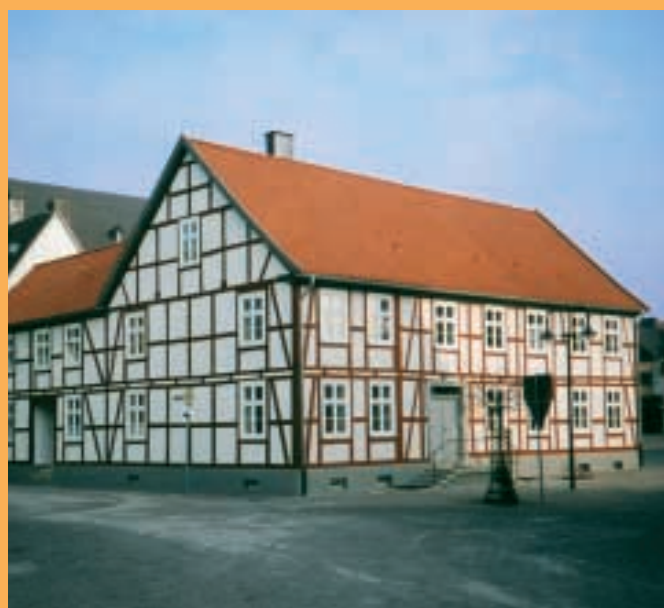
Pfarrhaus Niedermarsberg – Der Sanierung dieses Pfarrhauses in Niedermarsberg ging eine vollständige Entkernung voraus. Hinter der Fachwerkfassade, die mit weichen Vollziegeln, sog. Feldbrennern, und traditionellem Putzaufbau ausgeführt wurde, bildet eine Mauerschale aus Leichthochlochziegeln das neue Tragwerk. Planung und Ausführung: Architekturbüro Simon, 58706 Menden.
