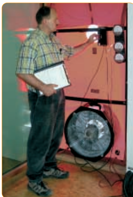
Qualitätskontrolle durch einen Luftdichtheitstest (Blower-Door-Test)
